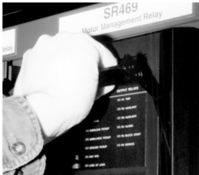
Figura 2-9 GIRE LA MANIJA HASTA LA POSICIÓN TOPE
